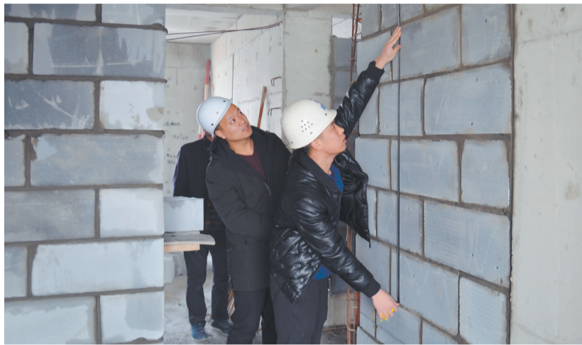
项目工程部人员严格检查施工质量
