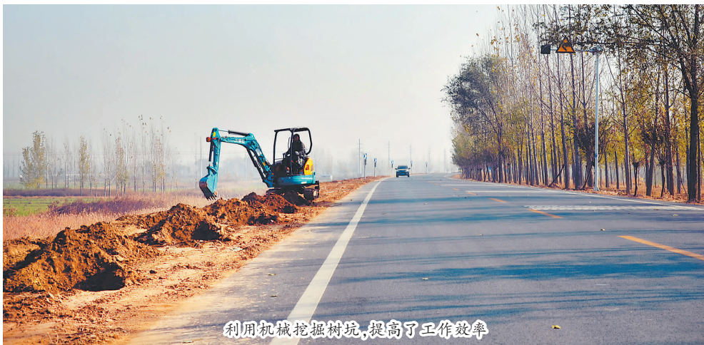
利用机械挖掘树坑,提高了工作效率
