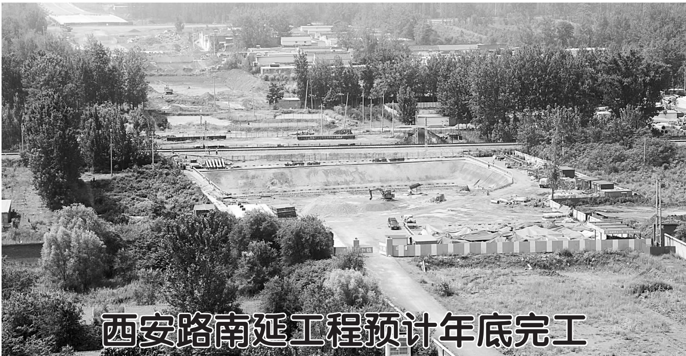
▲西安路南延工程起于长江路与西安路交叉口，沿西安路南延改线，向南穿原菏泽监狱五监区，下穿新兗铁路，出牡丹区境，与定陶县相接。路线全长 14.427 公里，除起点段 1.89 公里为新建，其余路段均为老路加宽，整个工程预计年底完工。
