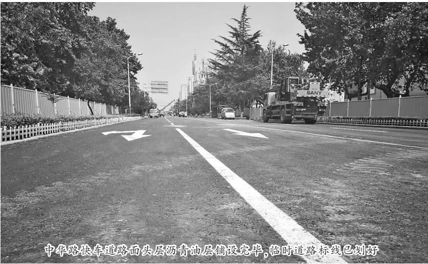
中华路快车道路面头层沥青油层铺设完毕，临时道路标线已划好
