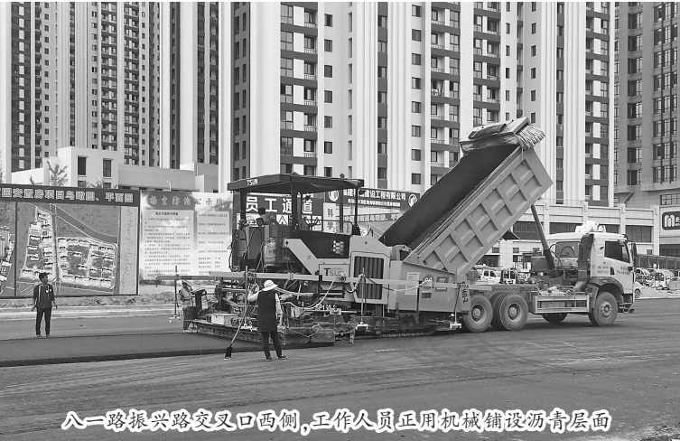
八一路振兴路交叉口西侧，工作人员正用机械铺设沥青层面
