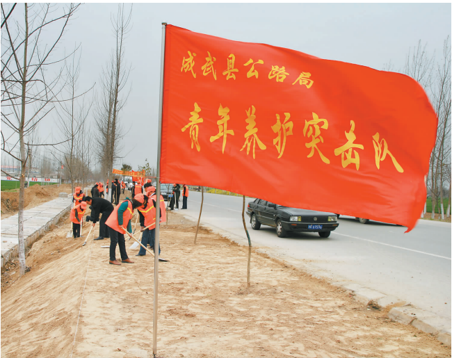
公路养护现场
