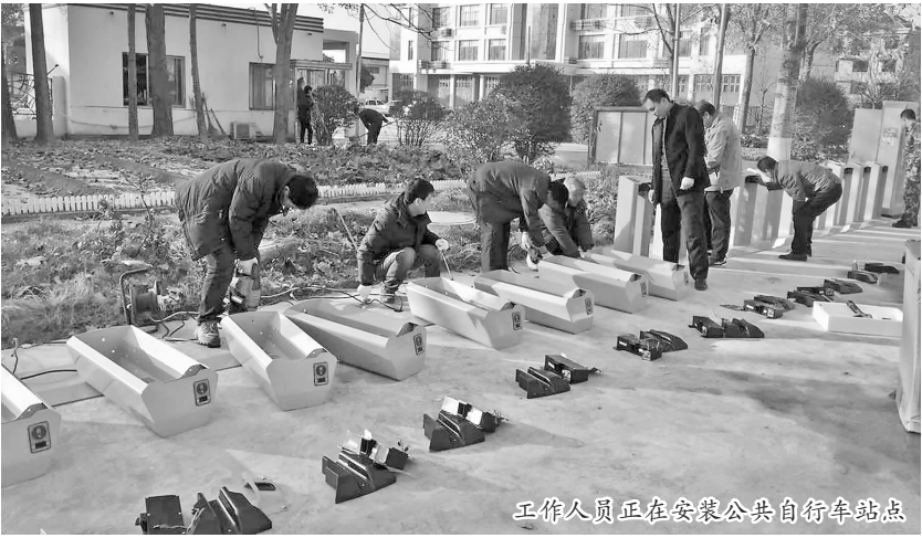
工作人员正在安装公共自行车站点
