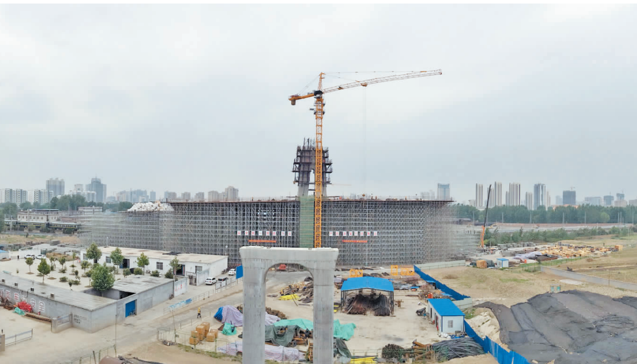
5月27日,亚洲转体重量最大的桥梁——丹阳立交桥东侧引桥正在进行桥面铺装,西侧引桥已经全面开工,目前跨越货场的主桥正在满铺脚手架,计划6月下旬开工建设。据介绍,整个丹阳立交桥工程将在今年年底建成通车。丹阳立交桥的建立将直接贯穿我市东西城区,备受市民关注。 记者 王众 摄
