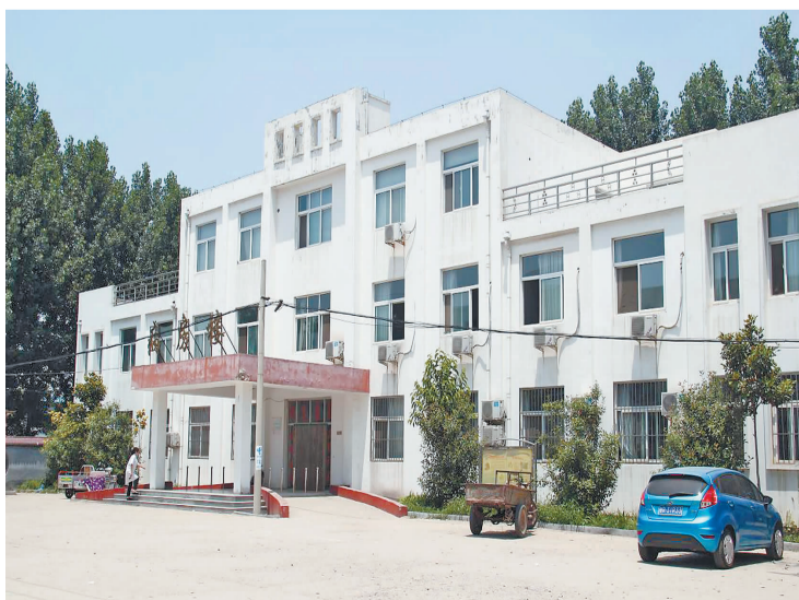
牡丹区王浩屯镇中心卫生院住院楼掠影
